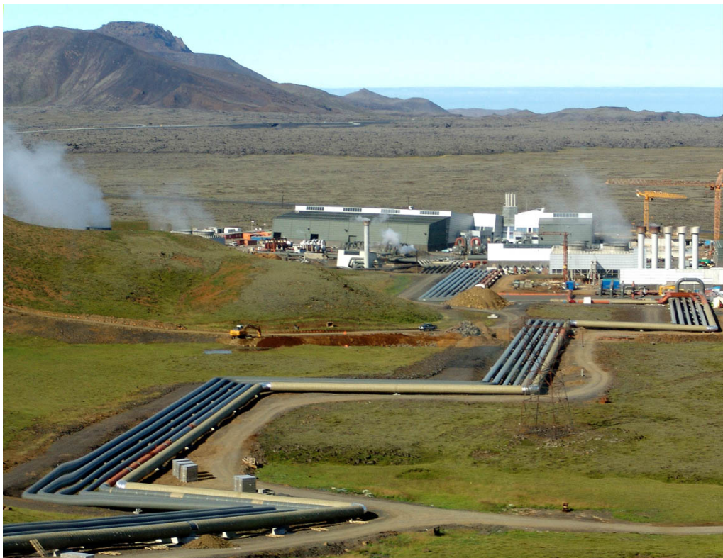
Рис. 2. Геотермальная станция в районе г. Рейкьявика (Фото А.Ю. Озерова)
