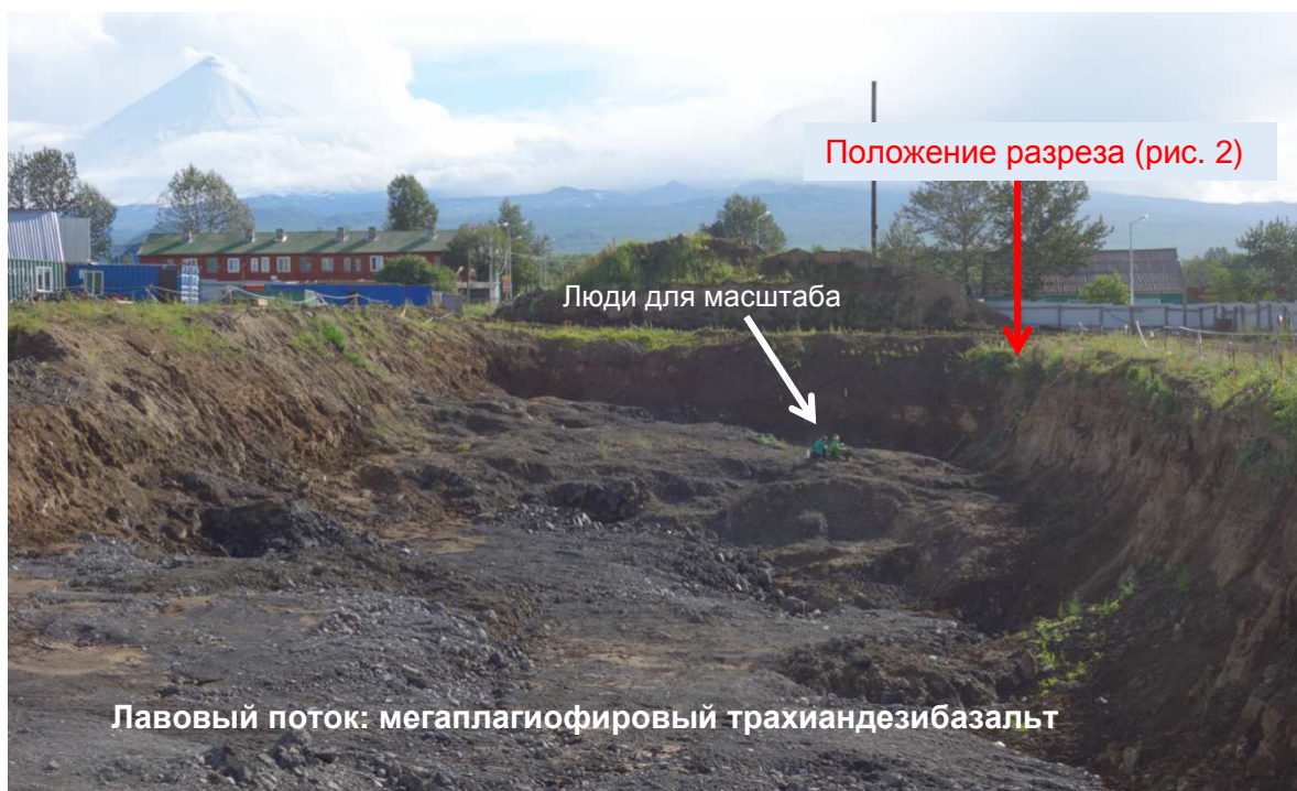
Рис. 1. Поверхность лавового потока, вскрытая котлованом на ул. Школьной. В стенке котлована обнажаются рыхлые отложения позднеплейстоцен-голоценового возраста общей мощностью ~8 м (рис. 2).
