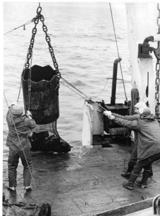
Рис.2.25. Подъем драги на борт судна.
