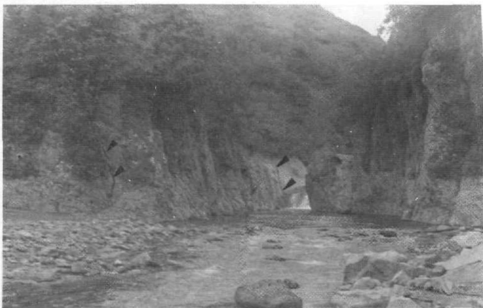
Рис. 9. Район верхнего водопада на р. Карымской (т.н. 35 на рис. 3). Вид с севера. На скальных обрывах правого борта реки видны зияющие трещины, имеющие Az_{np} = 0^\circ , падение плоскости сместителя к западу 75-82^\circ
