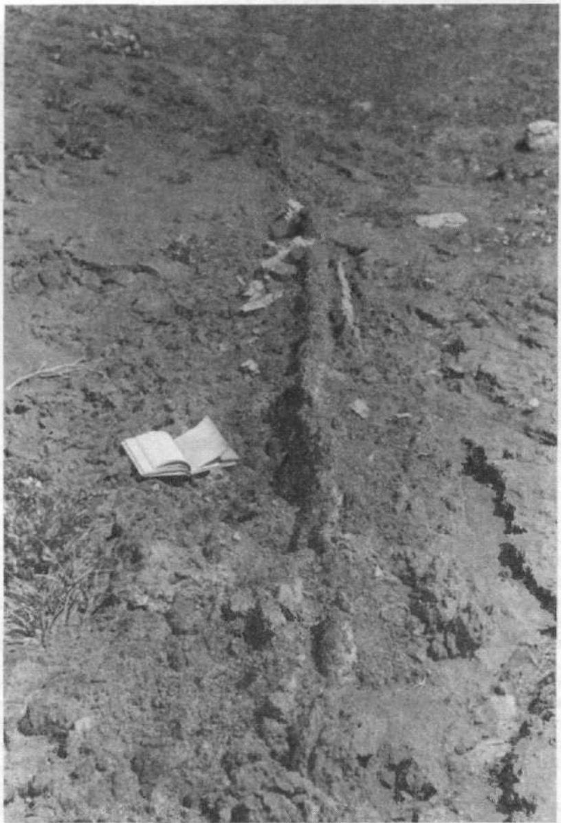
Рис. 10. Хребтики выдавливания над трещинами и т.н. 50 (см. рис. 3)
