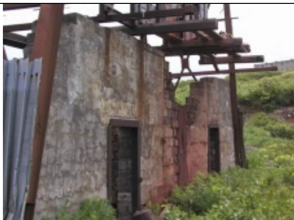
Рис. 4 м, н, о. Металлокаркасные строения со шлакоблочными стенами на территории ДЭС.
