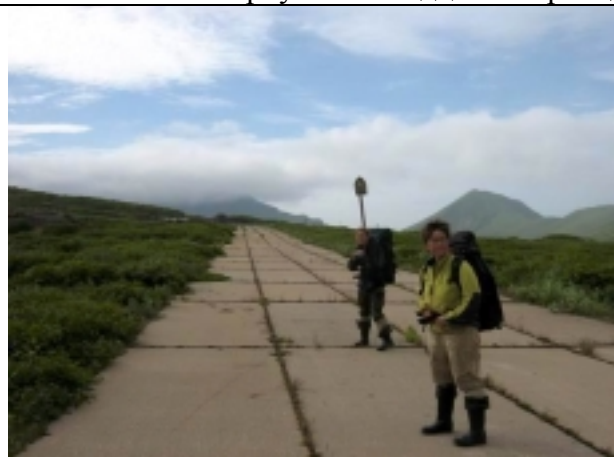
Рис 5 а, б. Взлетно-посадочная полоса из армированного заливного бетона. Деформации и трещины отсутствуют.
