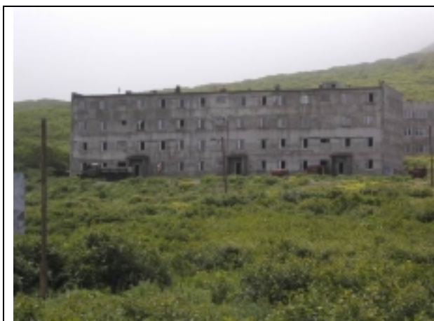
Рис. 4 ш, щ, э. Многоэтажные бетонные дома в пос. Кратерном.
