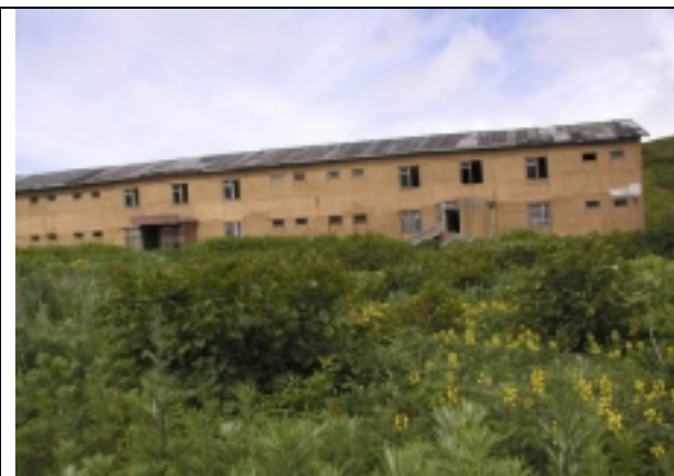
Рис. 3 а. Деревянный дом в бетонно-цементной армированной «рубашке» по адресу Коммунистическая 2 (№ 10 на рис. 2).
