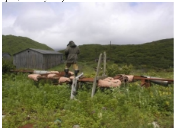
Рис 5 в, з. На территории поселка разрывов и значительных деформаций в наземных трубопроводах не выявлено.
