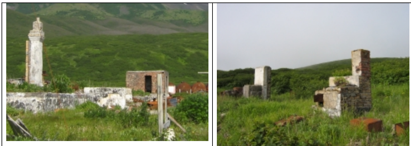
Рис. 9. Кирпичный сарай не пострадал во время землетрясений, кирпичные печи так же не развалились.
