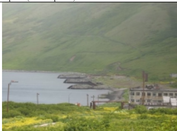
Рис. 4 я. Бетонные основания плавучих пирсов на берегу бух. Броутона.
