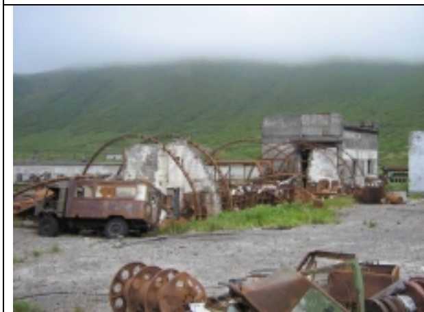
Рис. 4 ю. Территория котельной (№3 на рис.2).
