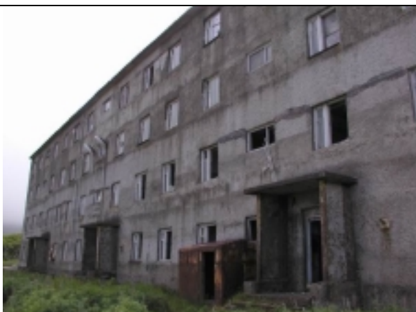
Рис. 4 ф. С внешней стороны здание (№18 на рис.2) практически не имеет повреждений.
