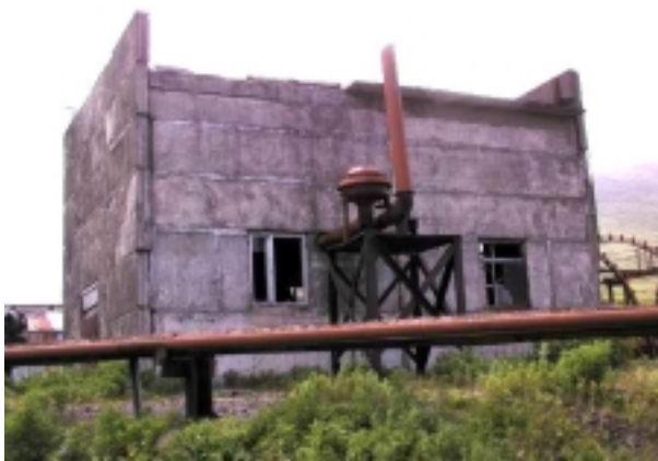
Рис. 4 з. Здание ДЭС (№ 22 на рис. 2)
