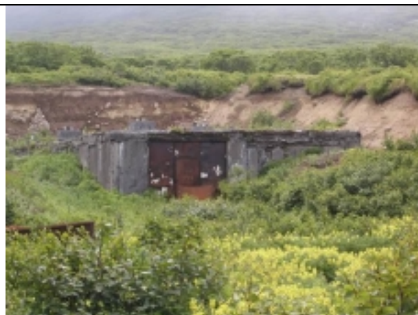
Рис. 4 л. Бетонный гараж на территории аэродрома.
